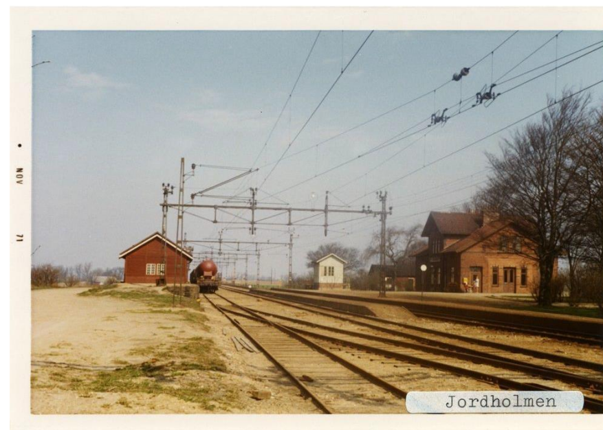
Jordholmens station 1971 med lastkaj och godsmagasin, litet ställverksbhus och bakom stationshuset skymtar avträde. Till höger om stationen anar man stationsplanteringen. Numera finns endast stationshuset kvar. Foto: Sveriges Järnvägsmuseum KDAD00776.
