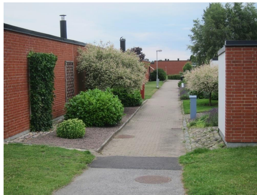
Grupphusbebyggelse från 1970 -talet bestående av villor och radhus i Vellinge. Bilfria gränder letar sig in mellan husen.
