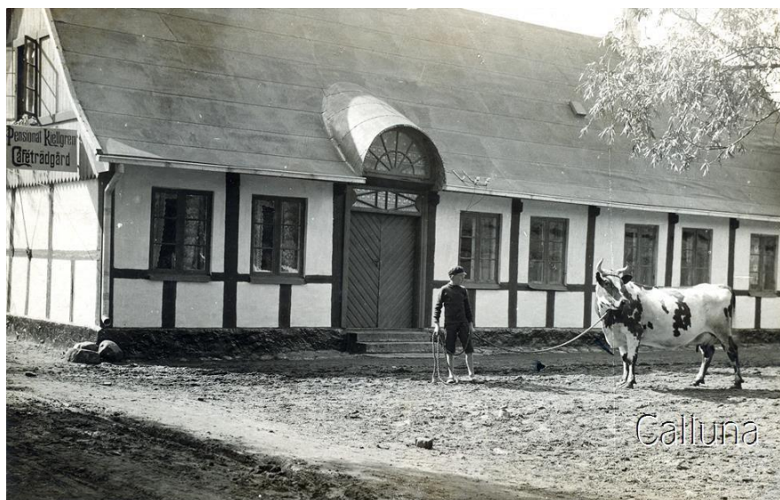
Korsvirkeslänga med bomeja (halmtaket har bytts ut till papp).
