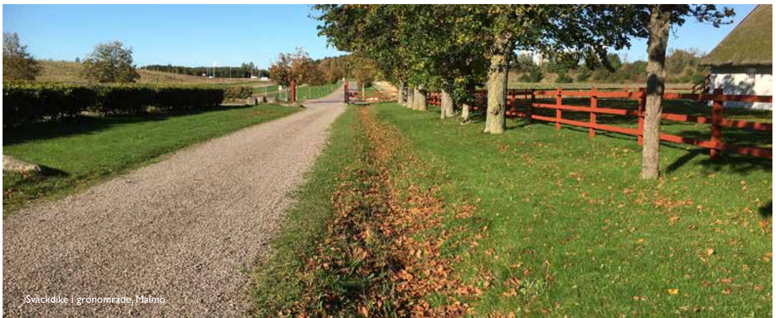
Förstärkt bortledning av häftiga regn, Köpenhamn Danmark.
