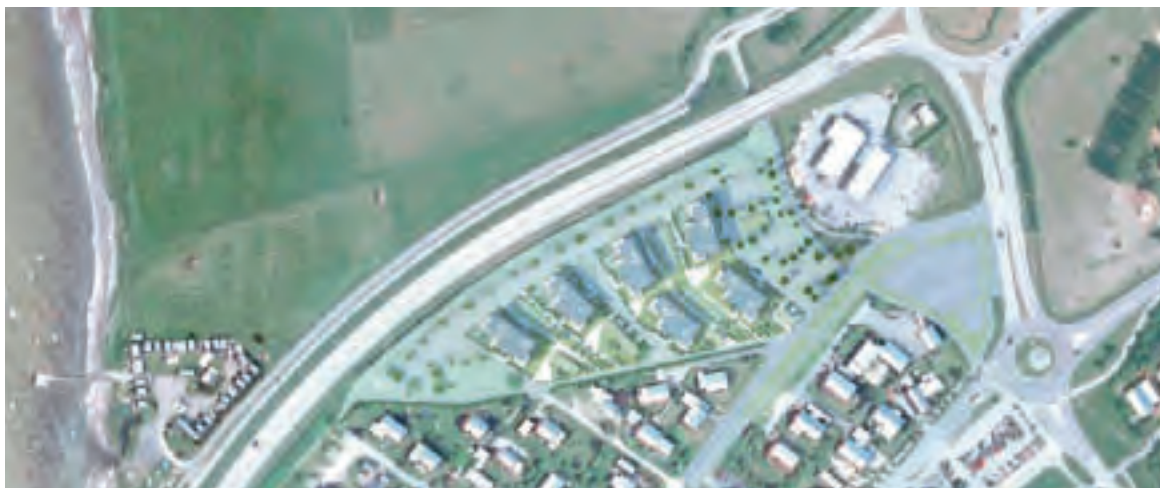
Höllviken - Förslag på kompletterande bostadsbebyggelse utmed väg 100. Detaljplanearbete pågår för området.
