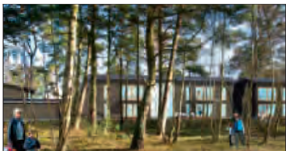
Detaljplan för White sands - Planerad byggnation med lägre flerbostadshus i tallskogen nära strand och hav i de södra delarna av Höllviken.
